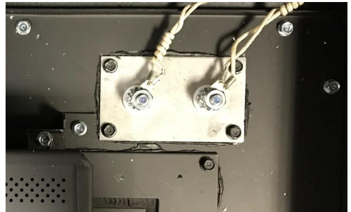
LES DEUX LAMPES SONT BRANCHÉES
