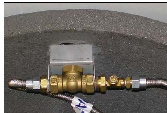
Valve à clé décorative installée. Vue de l'intérieur
