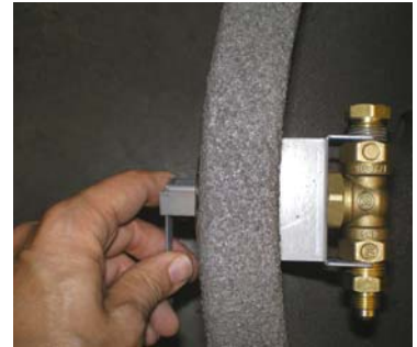
Serrez le chemin de clé avec l'outil
