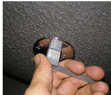
Serrez le chemin de clé avec l'outil
