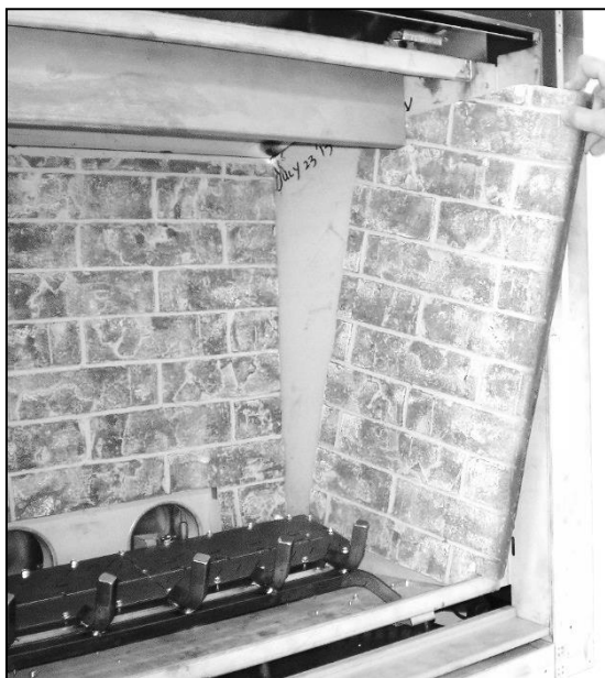
Étape 3 : Inclinez et glissez en place les doublures de gauche et de droite.
